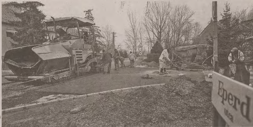
Új aszfaltréteg került burkolatként az utcákba
